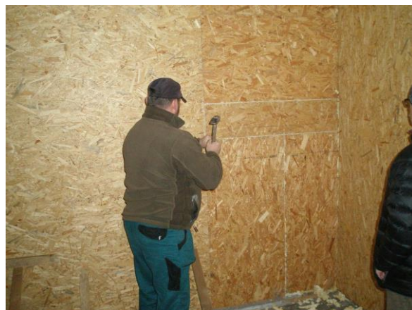
utěsnění místnosti po pokládce betonu
