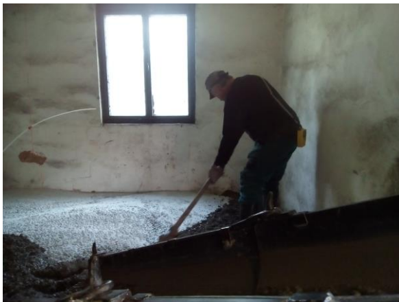
měřicí místo – pokládka betonu
